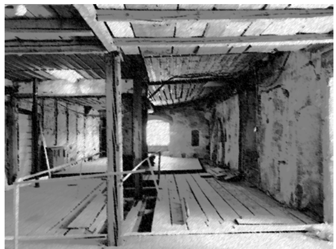
Zwischennutzung Hof zu Wil - Hofzeit
